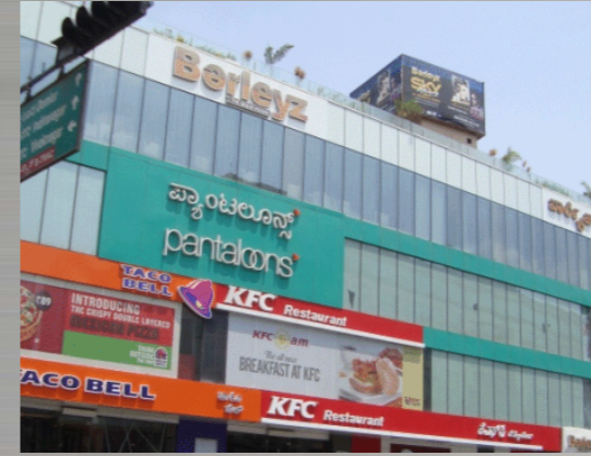
Padukone Plaza, Koramangala
