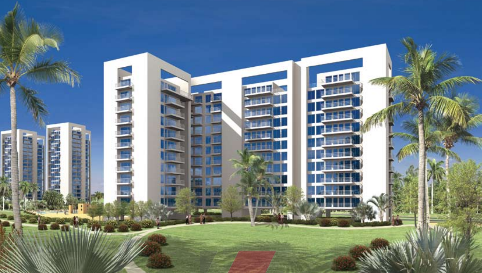
Actual Site Image
