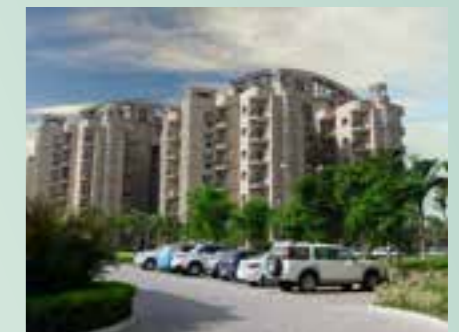
ATS PRELUDE Dera Bassi
