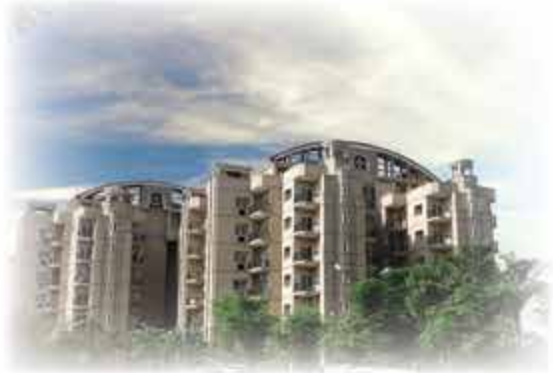
ATS PRELUDE Dera Bassi
