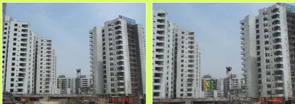
Actual Construction photographs
