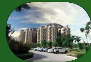
ATS PRELUDE Dera Bassi
