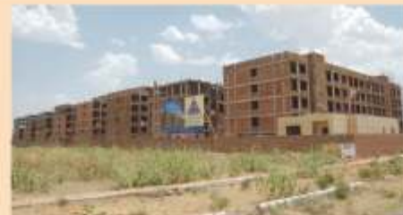
Actual Pictures of Construction Site
