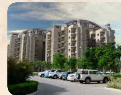
ATS PRELUDE Dera Bassi
